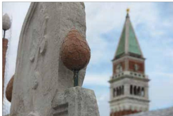
PG-DEBRIX® è una rete metallica a maglia esagonale a tripla torsione prodotta con filo di acciaio inox che trova utilizzo per proteggere e preservare gli edifici antichi e tipologie architettoniche storiche.
