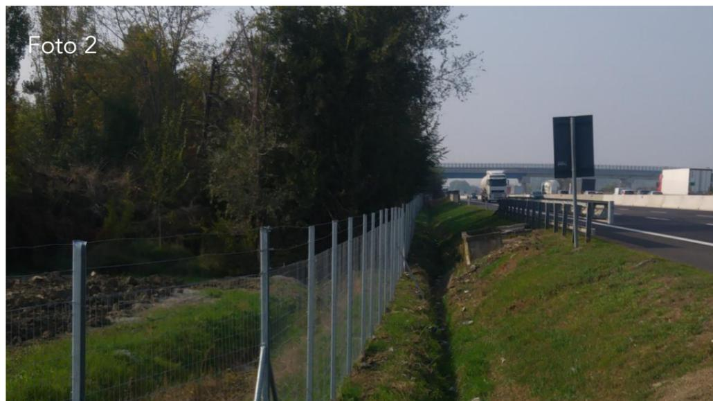
*La stesa ed il fissaggio della rete metallica di tipo R1B.*
